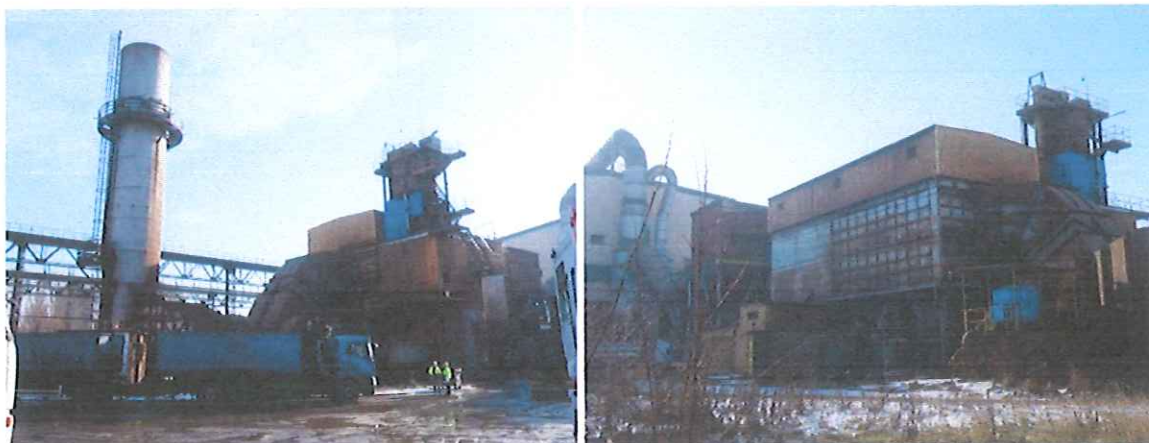
Widok budynku odpylni
