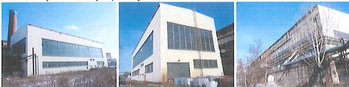
Widok budynku HMS (hala materiałów sypkich)
