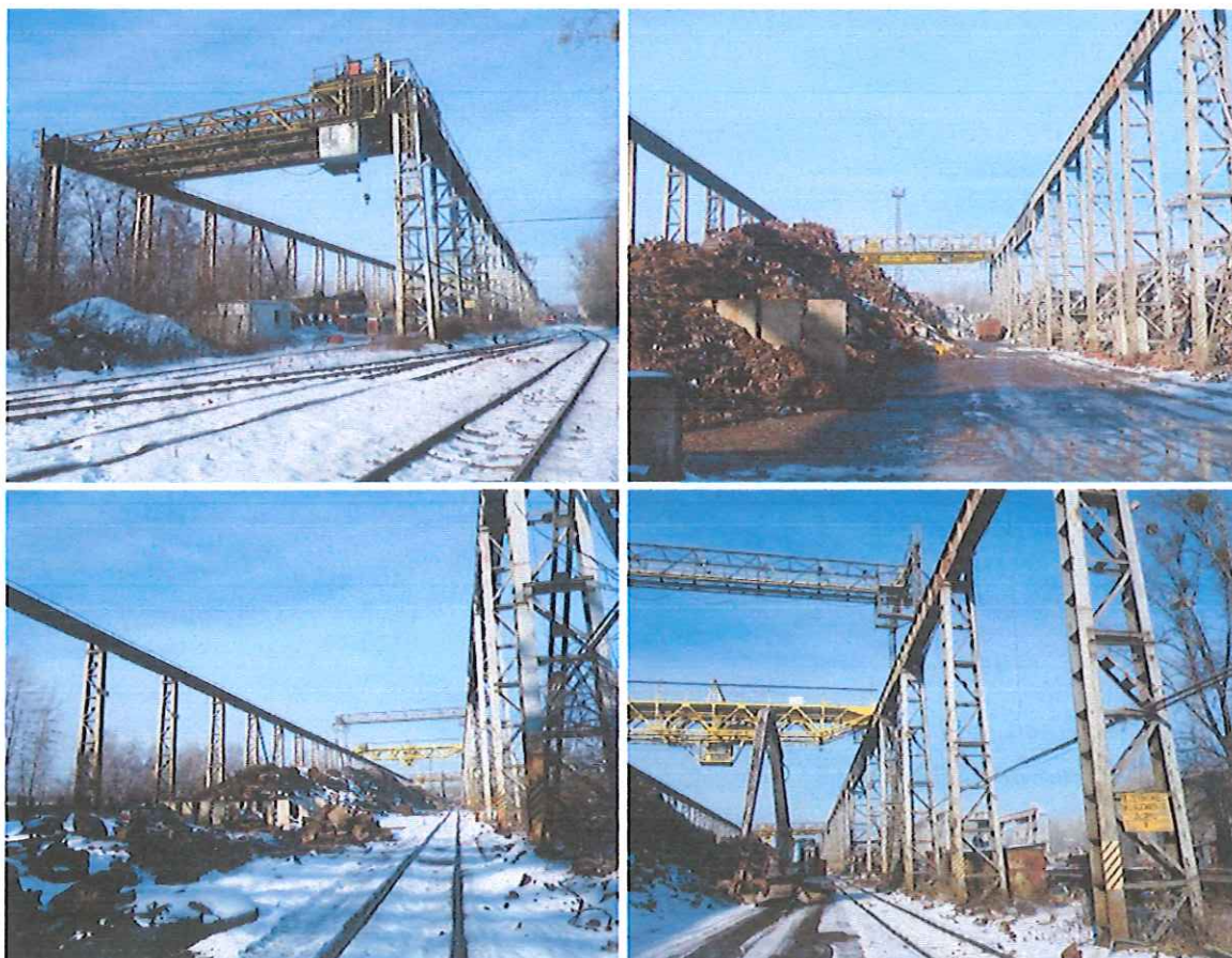
Widok estakady i składowiska złomu
