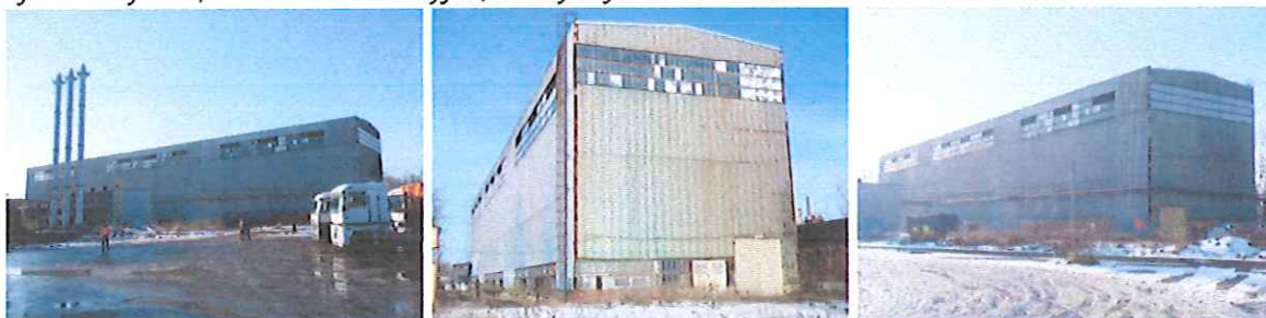
Widok budynku HMS (hala materiałów sypkich)
