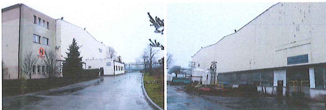
Widok hali walków i tulei
