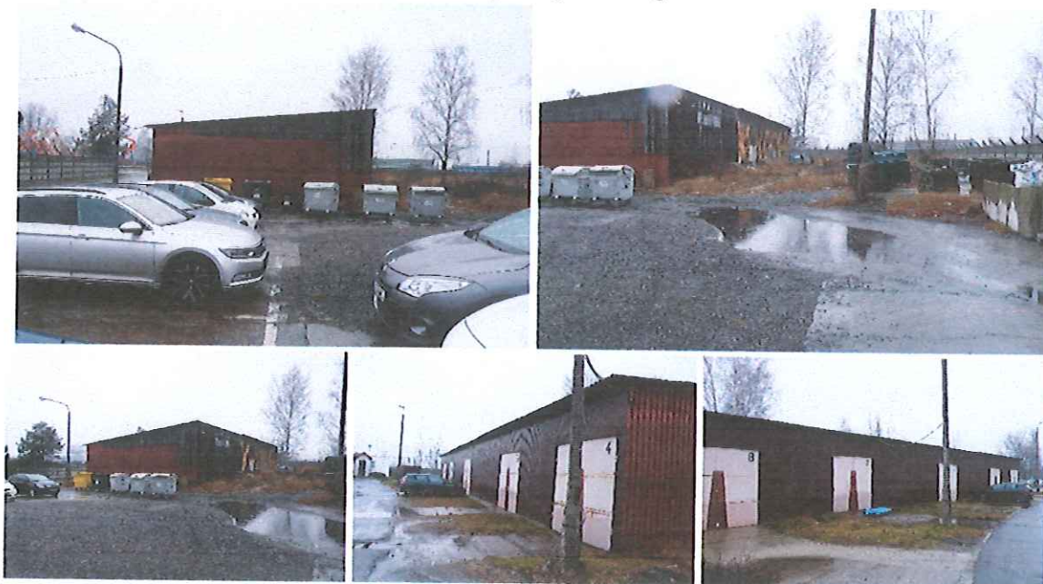
Widok budynku garażowego
