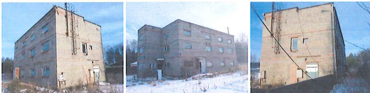
Widok budynku biurowego wyłączzonego z eksploatacji
