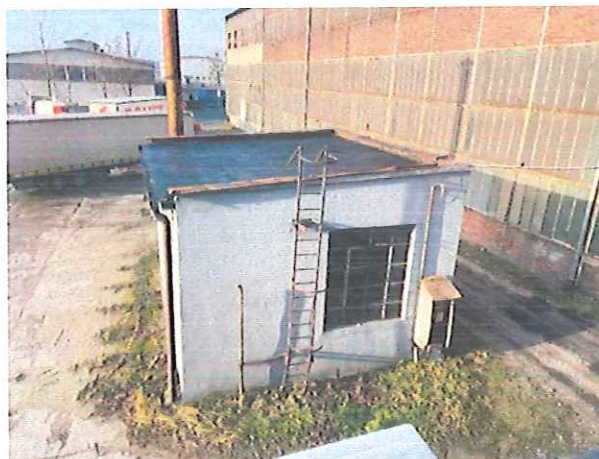
Budynek topialni smoly
