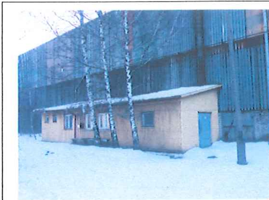
Budynek socjalny magazynu wsadu
