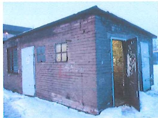
Budynek przy suwnicy
