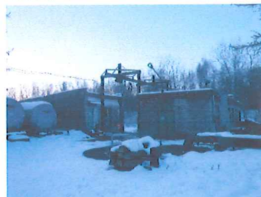
Budynek socjalny pompowni obiegu B
