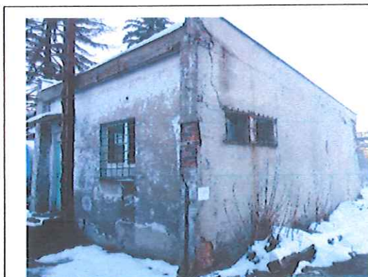
Budynek pompowni obiegu B
