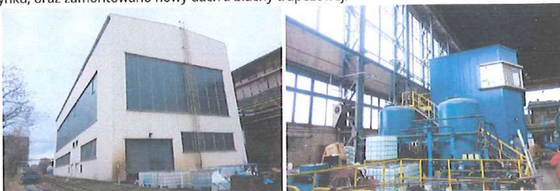
Widok pompowni wody
