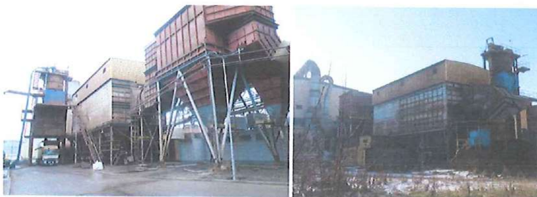
Widok budynku odpylni
