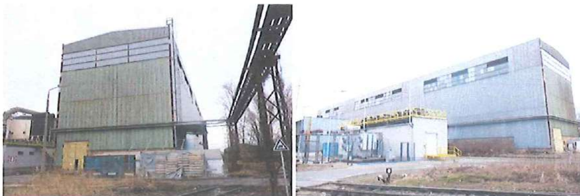
Widok budynku HMS (hala materiałów sypkich)
