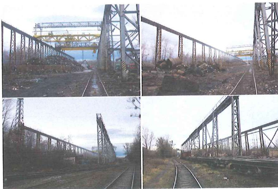
Widok estakady i składowiska złomu
