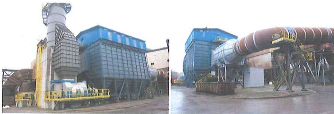
Widok nowej odpylni
