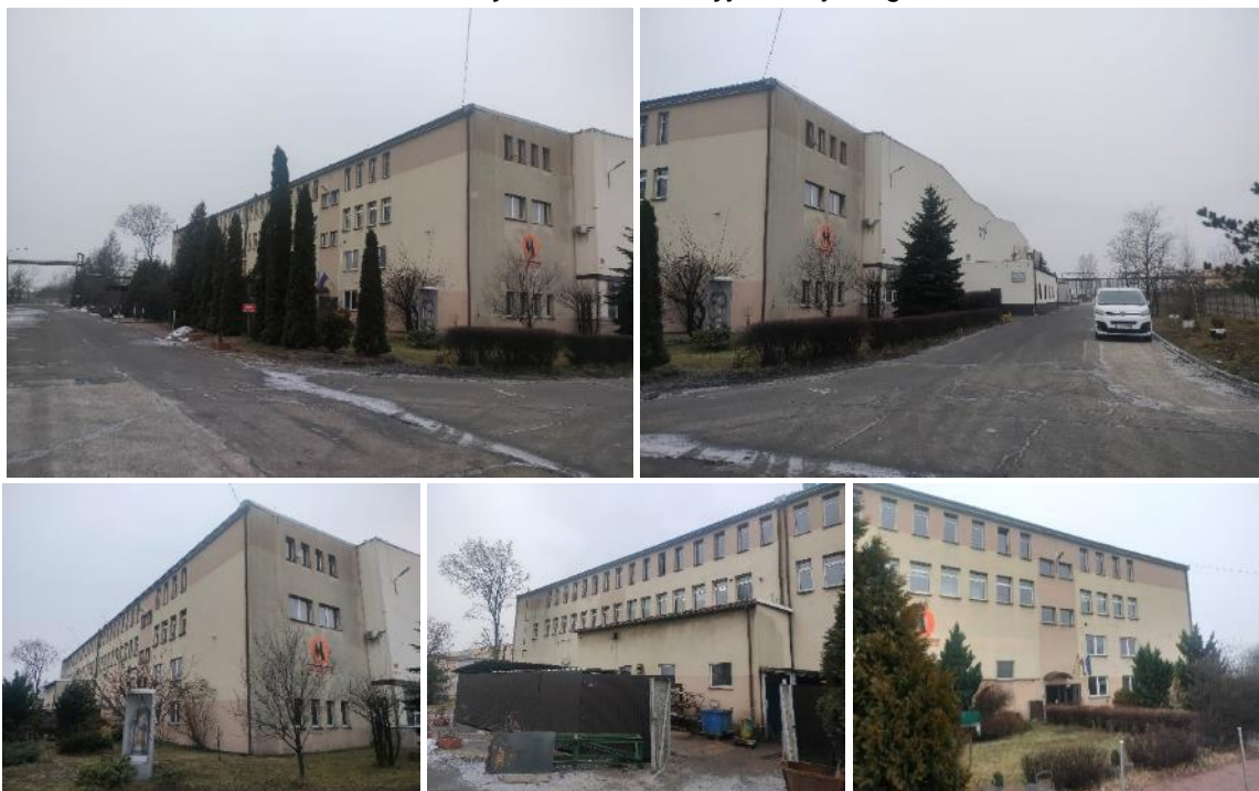
Widok budynku administracyjno-socjalnego
