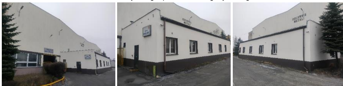
Widok budynku gospodarczo-magazynowego
