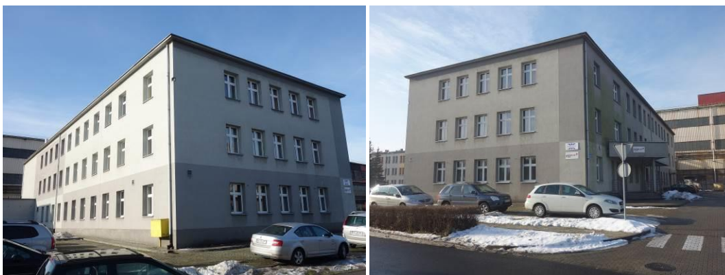
Widok budynku biurowo - socjalnego
