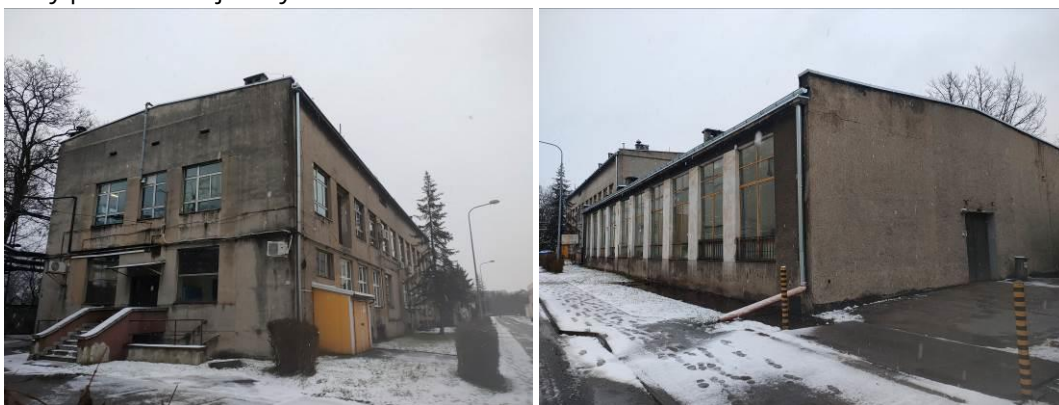
Widok budynku laboratorium
